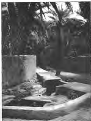
شكل رقم 5: يبين أسلوب بناء قنوات نقل مياه الفلج وتفرعها بين مواقع زراعة بساتين النخيل.
