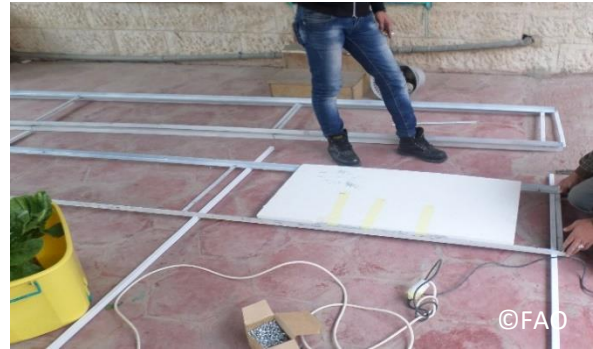
صورة 64: ضبط المسافات ما بين الزاويتين باستخدام قطعة من البولستيرين
