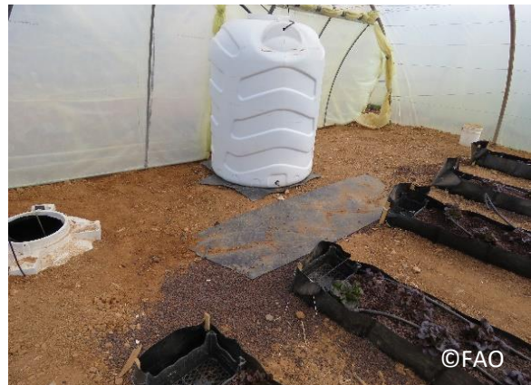
صورة 128: نظام ري بسيط يتواجد فيه خزانين صغيرين للمحلول المغذي داخل البيت المحمي
