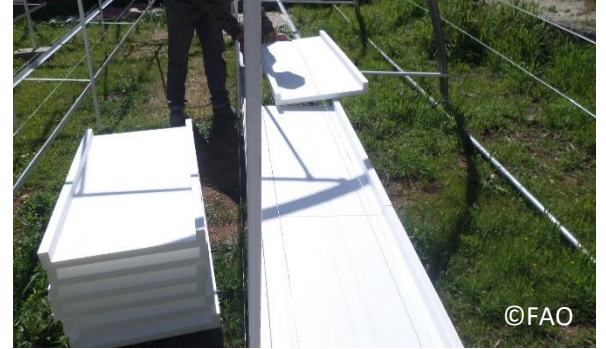
صورة 70: تركيب قنوات الزراعة على الهيكل المعدني
