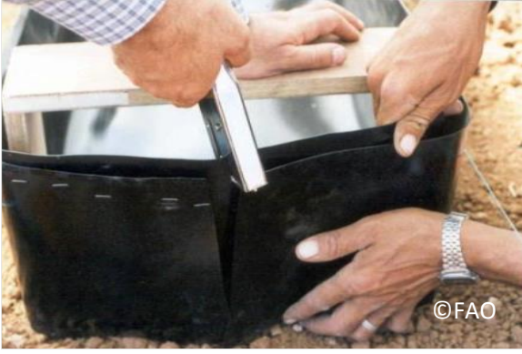
صورة 110: ثني نهايات القنوات وإغلاقها باستعمال مكبس الورق
