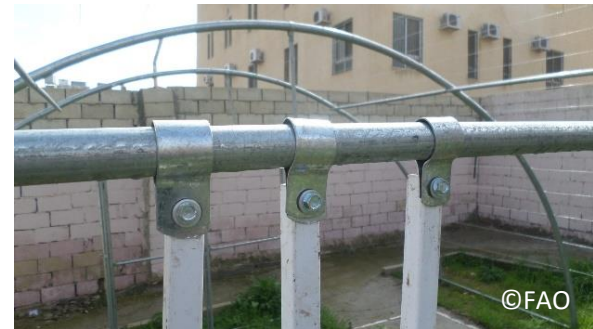
صورة 66: طريقة تركيب قطع الحديد المبسط المغلفن على حمالة المحاصيل
