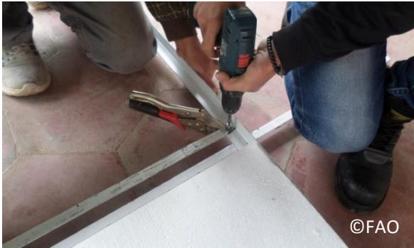
صورة 65: تثبيت المسافة بين الزاويتين باستخدام قضبان الحديد المبسط بواسطة البراغي
