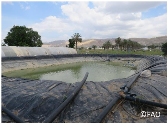
صورة 129: برك المياه التقليدية المحفورة في التربة والمبطنة بالنايلون
