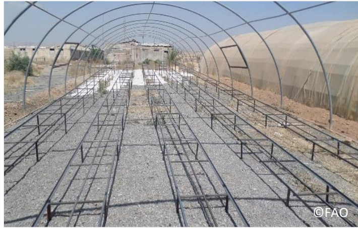
صورة 82: رفع الهيكل المعدني الأرض بواسطة
