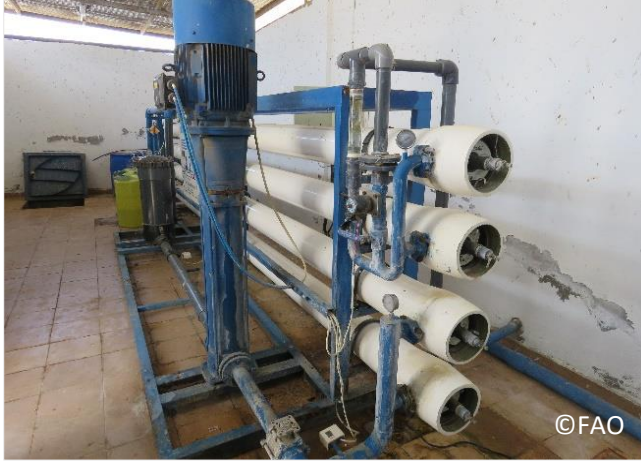
صورة 117: محطة لتحلية المياه باستخدام التناضح العكسي
