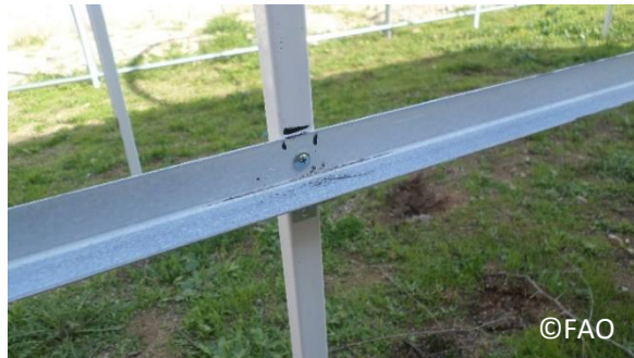
صورة 67: تثبيت الهيكل المعدني الحامل للقنوات بالبراغي
