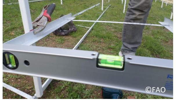
صورة 68: استخدام ميزان الماء الزئبقي عند المعايرة
