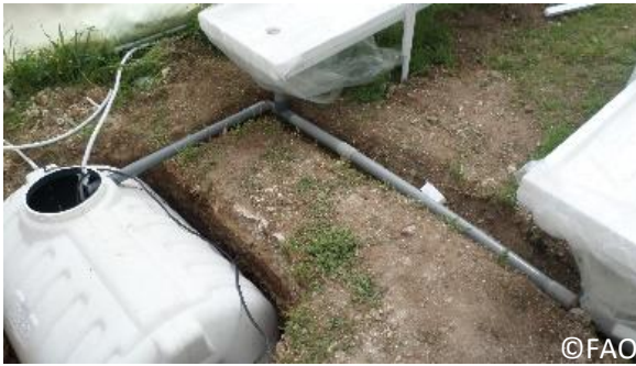
صورة 79: شبكة الصرف وخزان التجميع
