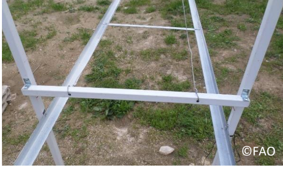
صورة 69: تركيب قطعة من الحديد المضلع المربع للتقوية ولتعمل كحامل لأسلاك التثبيت
