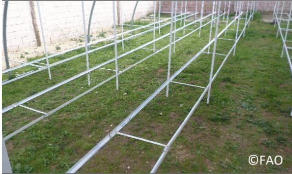
صورة 71: الجسم الحامل للقنوات معلق بالحملات
