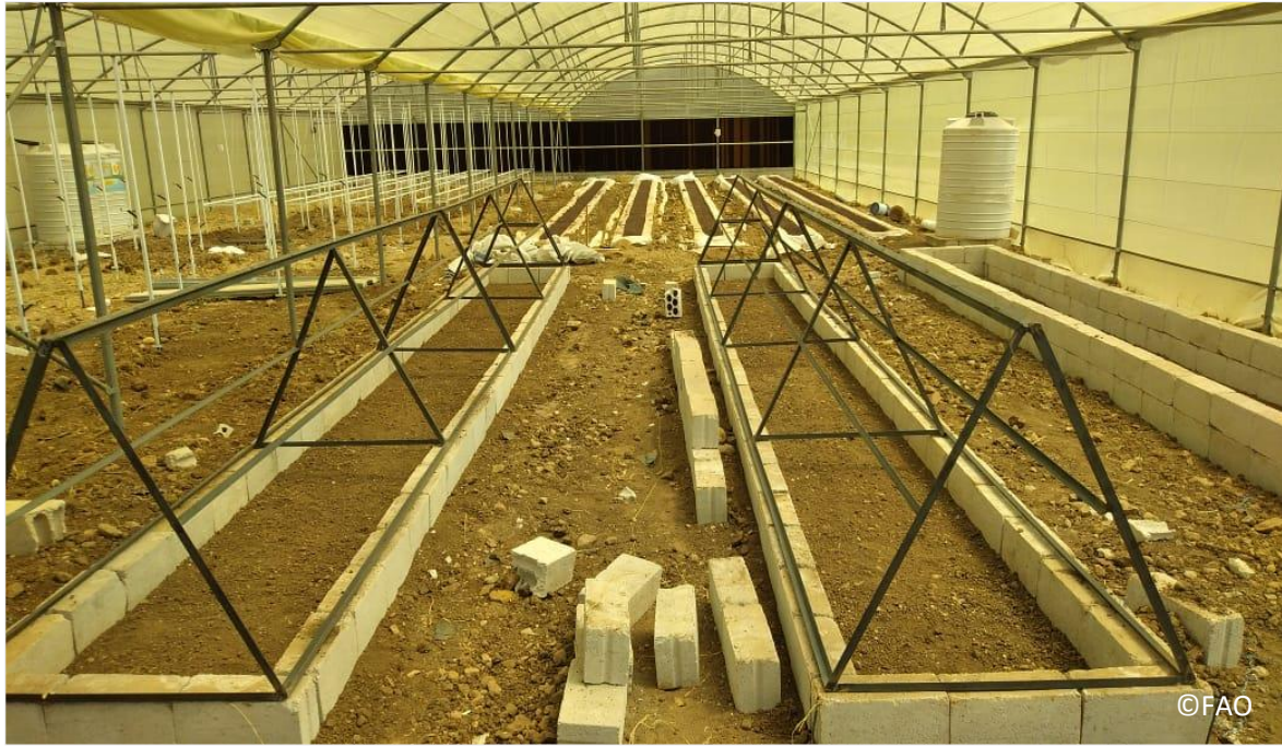
صورة 86: الهيكل المعدني بعد لحام أجزائه المختلفة
