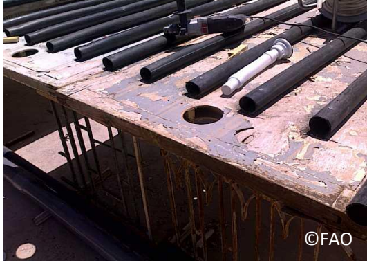
صورة 53: تركيب أنابيب المياه لتشكيل القنوات
