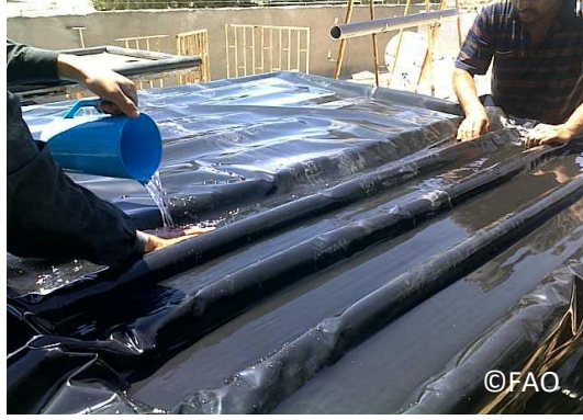
صورة 55: صب المياه لفحص التسريب
