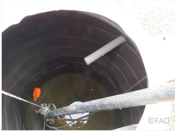
صورة 126: رفع أنبوب صرف الماء الراجع إلى الخزان
