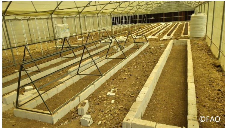
صورة 85: الأحواض المصنوعة من الطوب الإسمنتي
