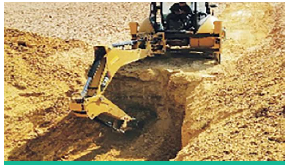
صورة (٩٣) حفر حفرة بعمق لا يقل عن ٣ متر
