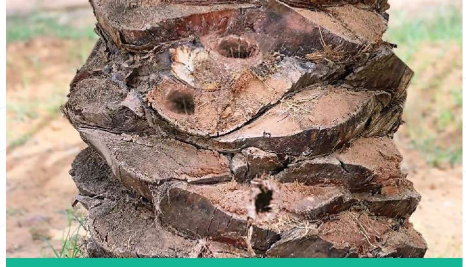
صورة (٦٩) وجود ثقب نتيجة الإصابة
