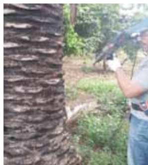
استعمال المثقب الكهربائي لحفر ثقوب الحقن حول موقع الإصابة
