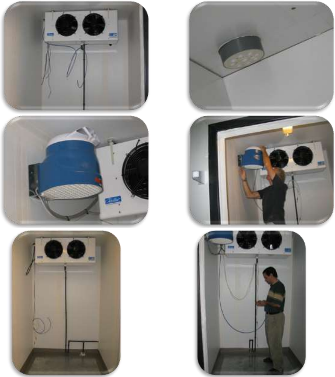
شكل ٣ - ١٣. صور تركيب وحدات التبريد والترطيب والمجسات داخل الغرف.
