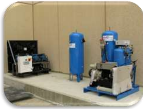
شكل ٣- ٤. وحدة توليد النيتروجين ووحدة التبريد على القاعدة الخرسانية.
