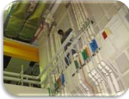
شكل ٣ -٨. صورة توضح أعمال خطوط الكهرباء.
