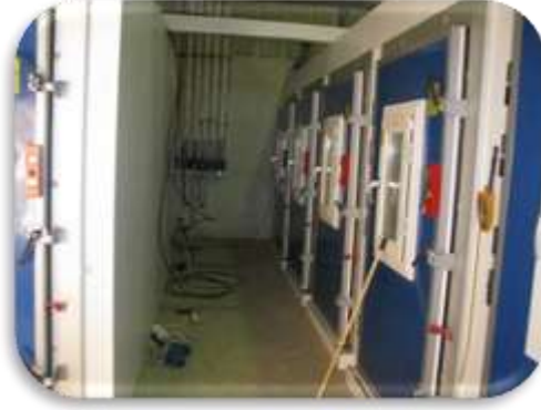
شكل ٣ - ١٢. صور تركيب الوصلات وأبواب غرف التبريد.
