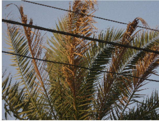
صورة ( □ ) اعراض التدهور بسبب اسلاك الكهرباء
