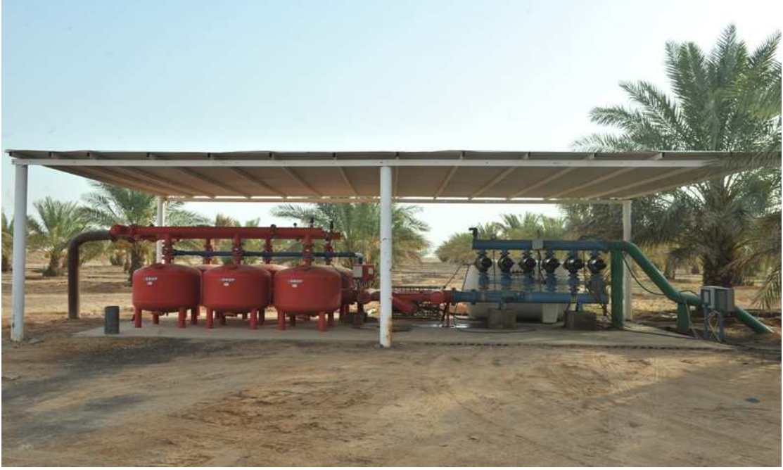
صورة (١٠): مكونات شبكة الري الحديثة - مشروع الباطن.
