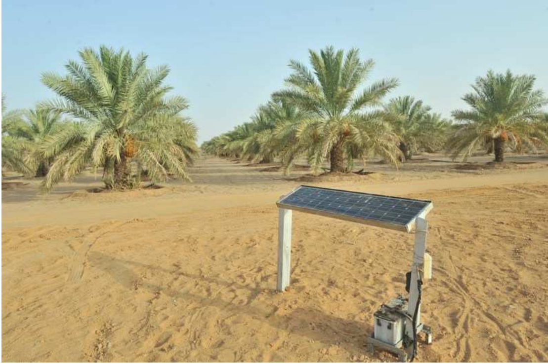
صورة (١٣): الخلايا الشمسية لتحويل الطاقة الشمسية إلى طاقة كهربائية- مشروع الباطن - القصيم.
