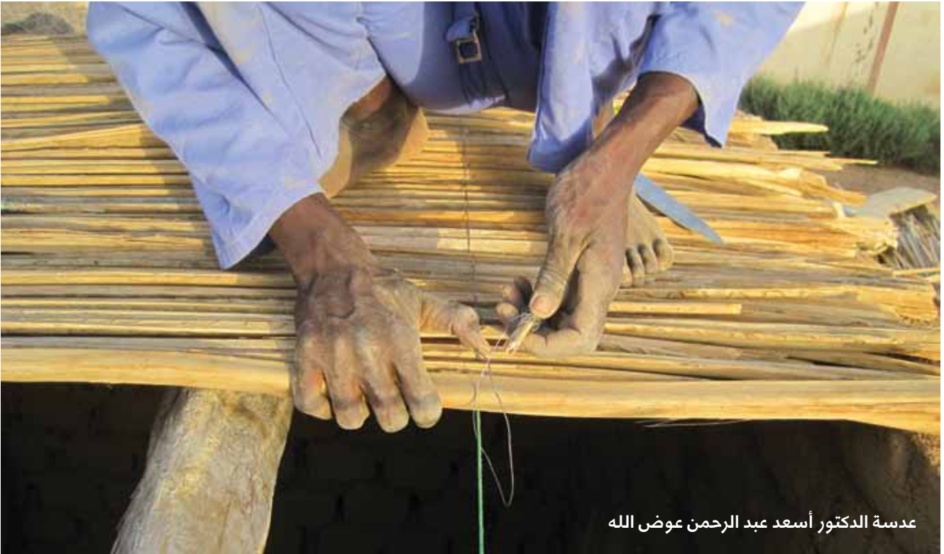
استخدام سعف النخيل وجريد النخيل بطريقة تراثية في بناء أسقف المنازل
