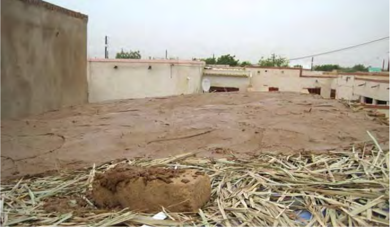
استخدام سعف النخيل وجريد النخيل بطريقة تراثية في بناء أسقف المنازل
