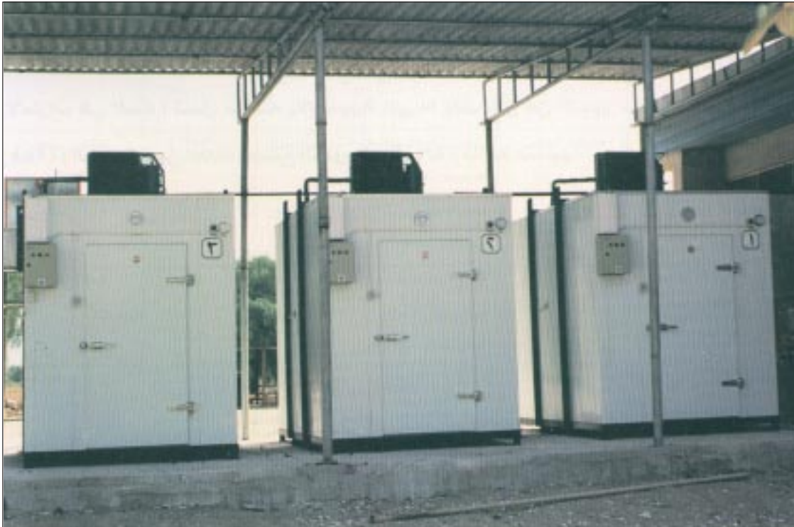
شكل (٢١). غرف تجارب خزن الرطب المبرد أو المجمد في محطة الأبحاث الزراعية في الحمراية (عن شبانة والشريقي ٢٠٠٠).
