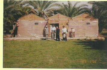
صورة ١: جذوع وسعف النخيل لإنشاء استراحة داخل بستان نخيل ( أ و ب )
