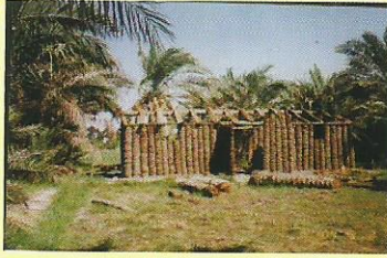
صورة ١: جذوع وسعف النخيل لإنشاء استراحة داخل بستان نخيل ( أ و ب )
