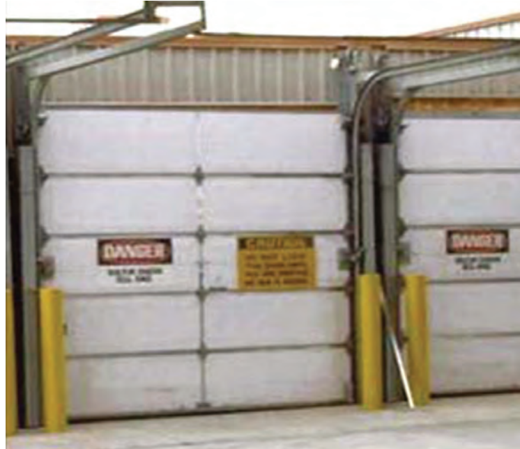
صورة لأحد المخازن المحكمة التي تستخدم في عمليات تبخير التمور في الموانئ
